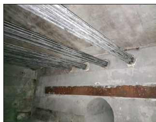
图 5 部分体外预应力筋图
