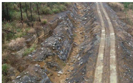
图8 渠道内侧破坏状况
